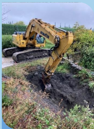
Avant le désengrèvement de l'ouvrage
