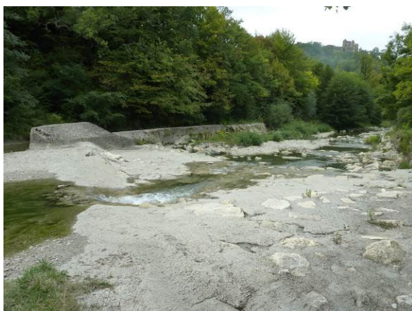
Vue du seuil en enrochements liaisonnés depuis la berge droite du Roubion (vue depuis l'amont)
