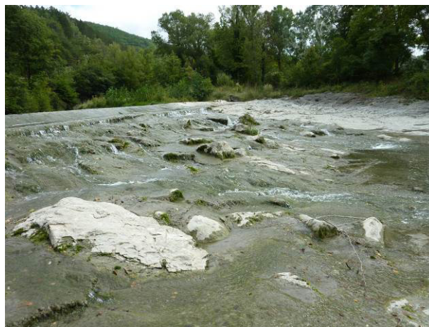
Vue du coursier en enrochements liaisonnés du seuil depuis la berge droite du Roubion
