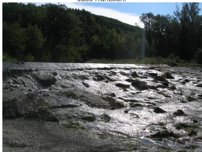
Seuil du moulin de Mornans, infranchissable à la remontée.
