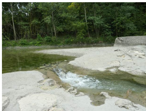
Vue de la crête du seuil induisant une chute d'environ 0.5m
