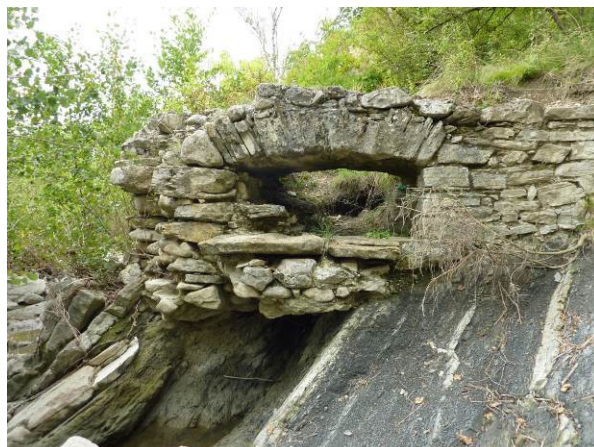
Vue de la prise d'eau et de l'extrémité amont du canal d'amenée en rive droite
