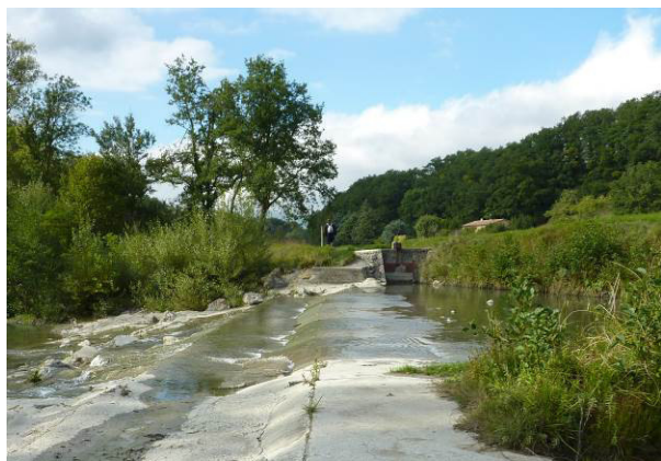
Vue de la crête en béton du seuil (1 er plan) et de la vanne de la prise d'eau située en rive droite (2 nd plan)
