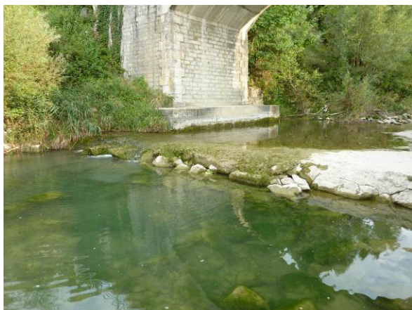
Vue de la chute induite par le radier du pont (octobre 2013)
