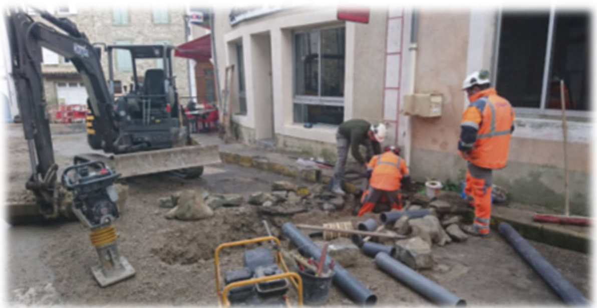
Figure 13 : Travaux de mise en séparatif des réseaux d'eaux pluviales et usées de la commune de Bourdeaux
