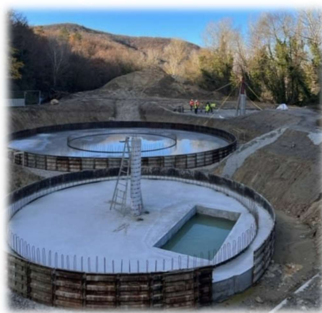
Figure 15 : Bassin d'orage à l'entrée de Dieulefit (400 m3) et la station d'épuration en construction
