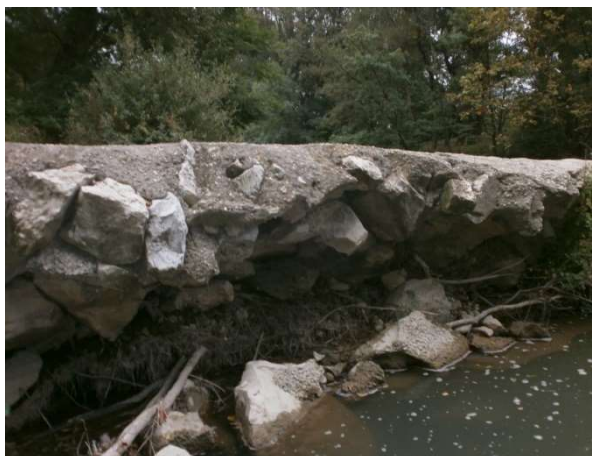
Vue du parement aval du seuil présentant un affouillement prononcé
