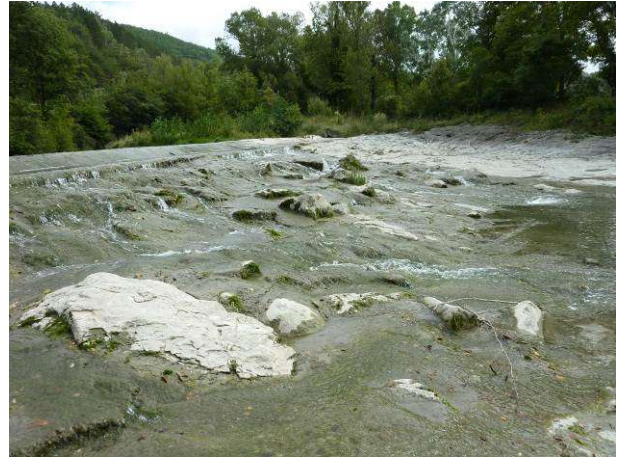
Vue du coursier en enrochements liaisonnés du seuil depuis la berge droite du Roubion
