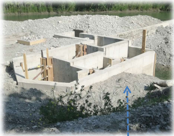
Passe à poisson en construction
