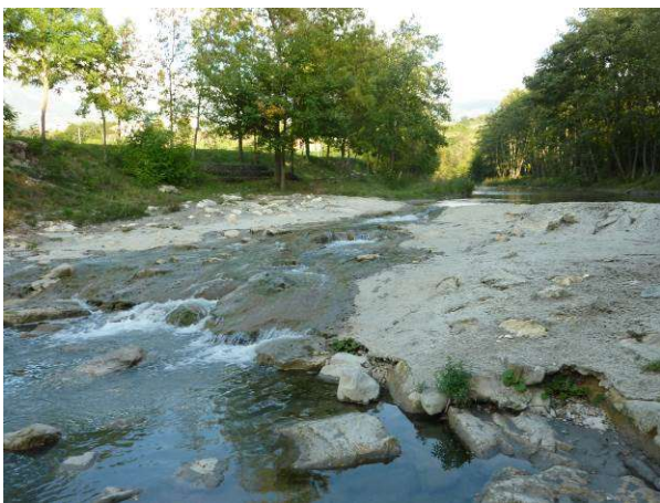
Vue du seuil en enrochements liaisonnés depuis la berge droite du Roubion (vue depuis l'amont)
