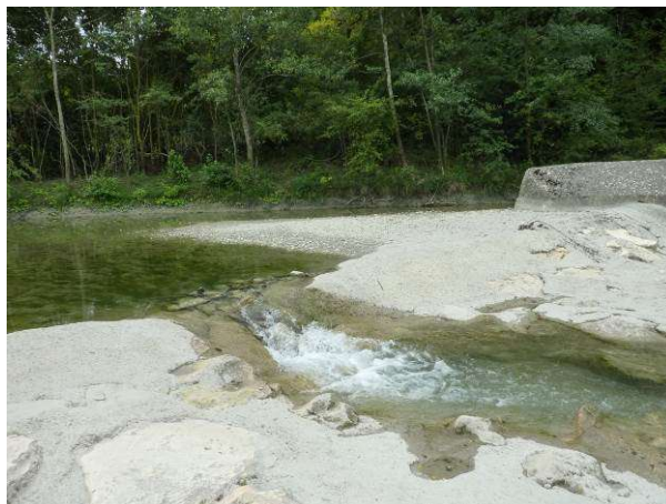
Vue de la crête du seuil induisant une chute d'environ 0.5m
