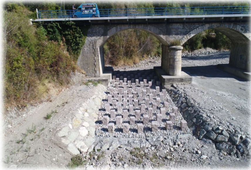
Rampe en assec directement post travaux (été 2019)
