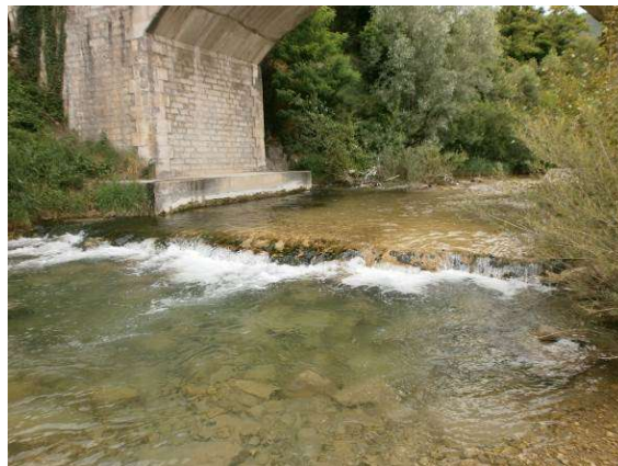
Vue de la chute induite par le radier du pont (juillet 2013)
