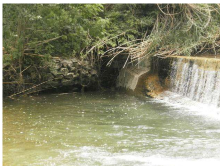
Vue de l'appui rive droite du seuil (gabion) présentant des signes de déstabilisation.
