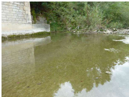
Vue de la faible lame (< 10 cm) d'eau au sein du lit vif au droit du radier du pont
