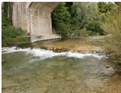
Vue de la chute induite par le radier du pont (juillet 2013)
