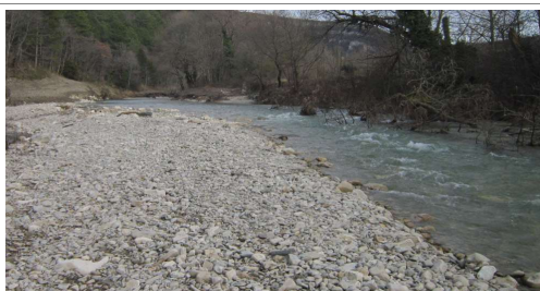
Post Travaux – Rehaussement du lit à l'aval, dépôt de matériaux post Q5, écoulements diversifiés (février 2019)
