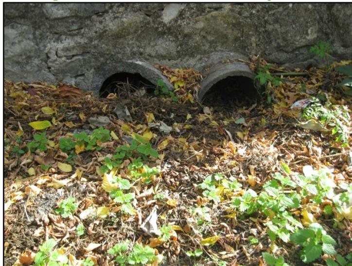
Figure 4 – Réseaux d'eaux pluviales obstrués (source : SMBRJ).
