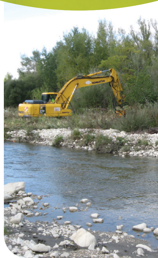
Broyage de la végétation sur un atterrissement
