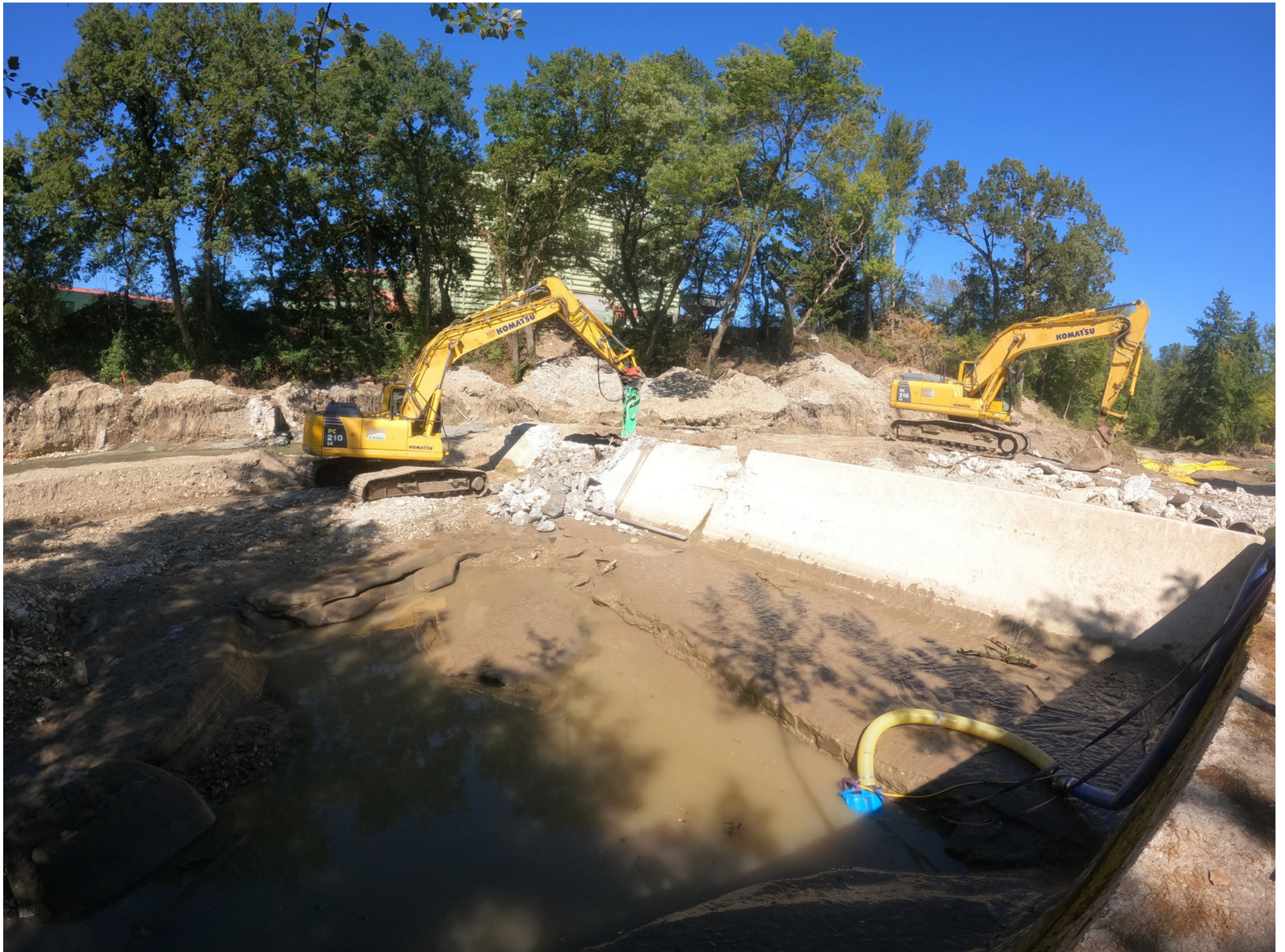
Effacement d'un seuil sur la Commune De Puygiron, sur le Jabron.
